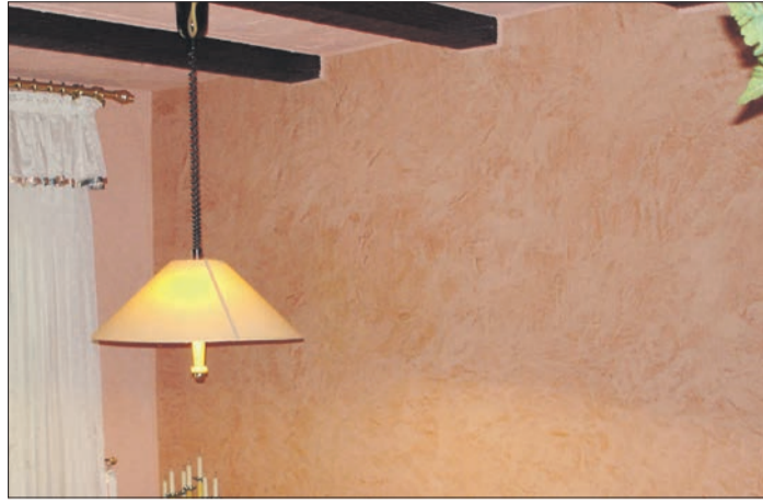
Glättetechnik – eine der vielen Stärken des Malermeisters. Foto: st
